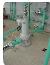
●テイコク地上型ポンプ シリンダー充填 ベーパーライザー供給
