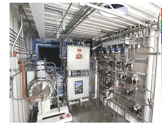
ISOコンテナ内に 組み上げられた PDCコンプレッサー、 計装機器及び制御
